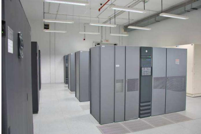
**Sistemi napajanja električnom energijom projektovani su tako da je moguće održavanje jedne od grana napajanja bez uticaja na funkcionalnost sistema u celini.**
