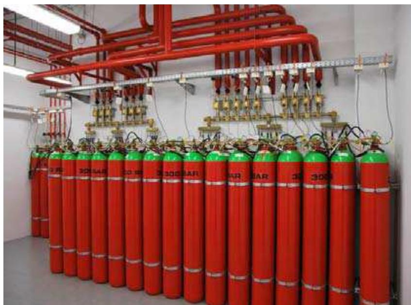
Data Centar je opremljen IG-55 gasnim sistemom za suzbijanje požara ("Argonit"), koji funkcioniše po principu dramatičnog smanjenja nivoa kiseonika u vazduhu, i to do nivoa koji onemogućava dalje širenje požara.
